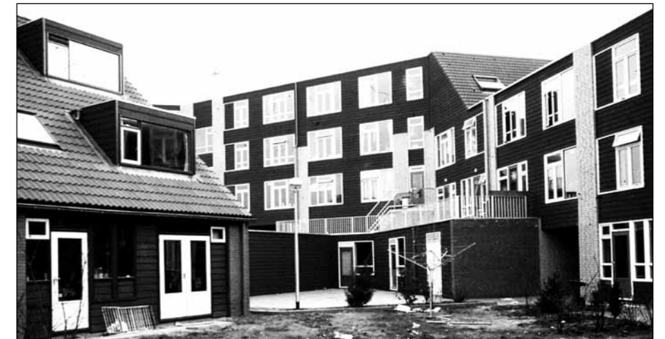
Een buitenbekleding van 'western red cedar'. Ook ongeschilderd met een onbeperkte levensduur. Links op de voorgrond is een dichtgezet deel van een kozijn te zien waarachter een keukenblad is gemonteerd. Ook rechts zijn, binnen de witte omlijnningen, dichtgezette kozijnen te zien.
