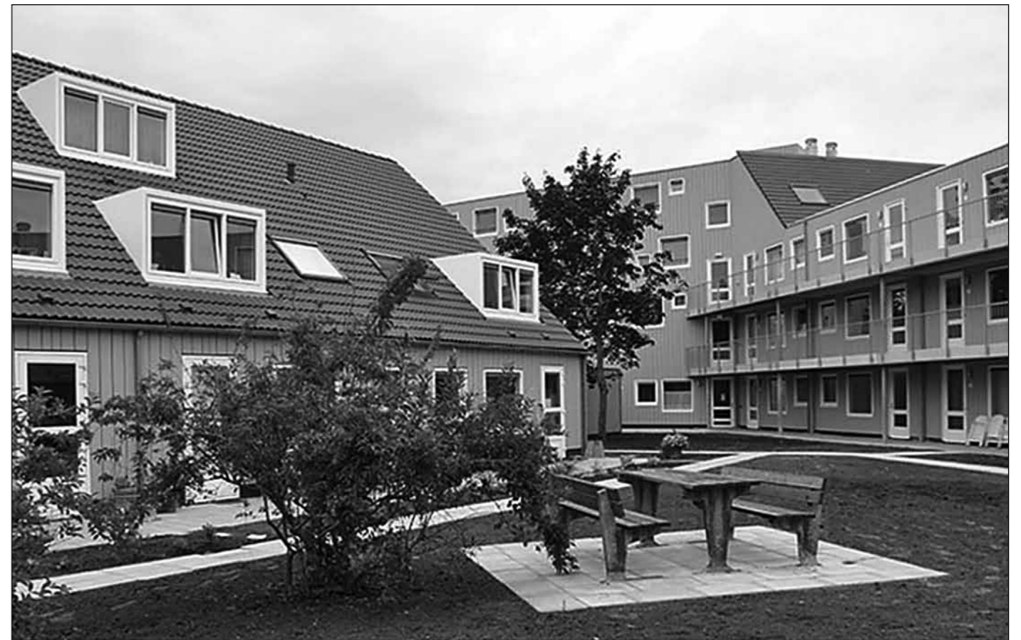
Zoals het er nu uitziet. Op de voorgrond de hof, met rechts de nieuwe galerijen met de toegangen van individuele woningen aan de kant van de hof. Op de achtergrond de woningen van Humanitas.
