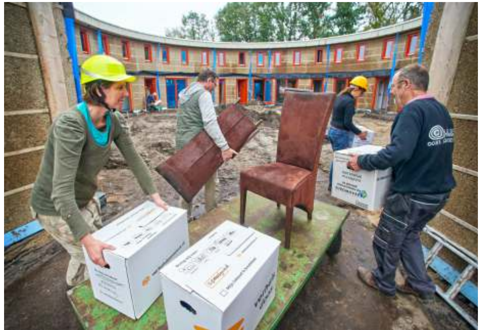
De eerste woningen zijn inmiddels bewoond
