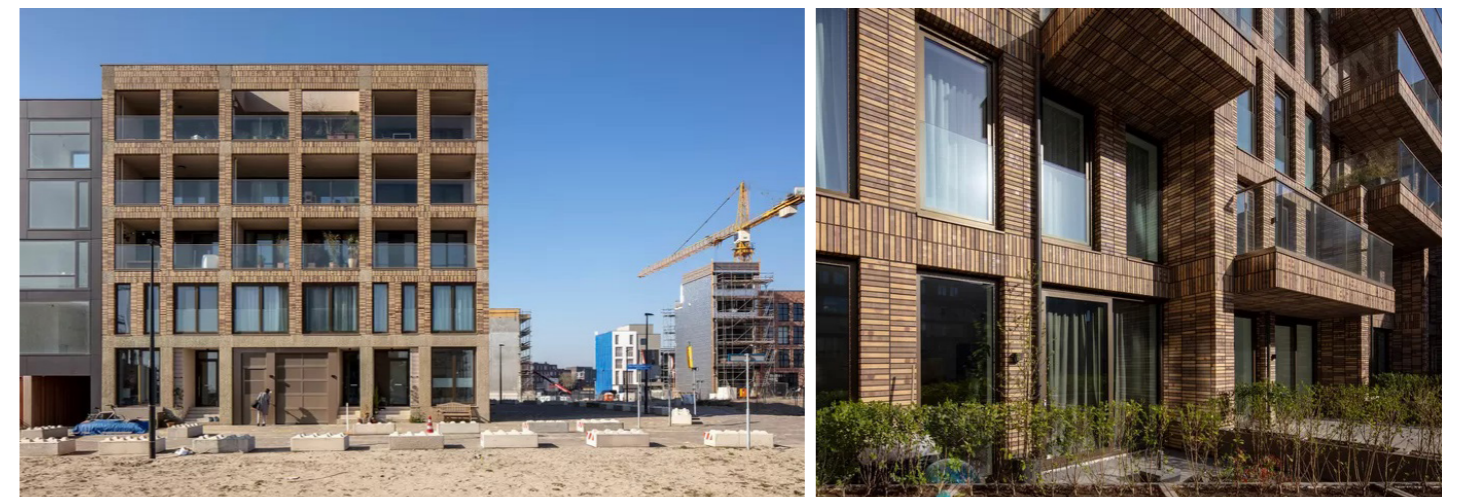
Cpo-project IJCE op IJburg Amsterdam, foto door: Jordi Huisman
